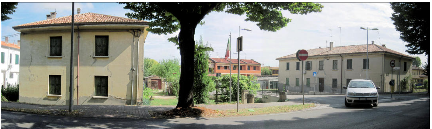
Vicolo del Volo (i due edifici in vendita con la previsione di ricavare 914.795 euro)
